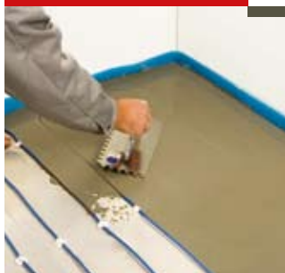
Нанесение выравнивающей стяжки
