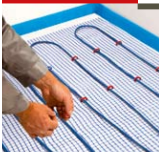
Укладка греющего кабеля
