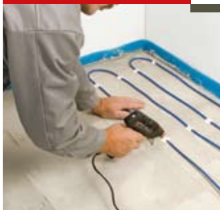
Укладка греющего кабеля
