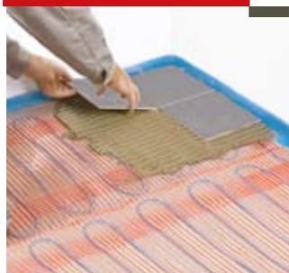
Нанесите слой клея и уложите плитку согласно инструкции производителя.
