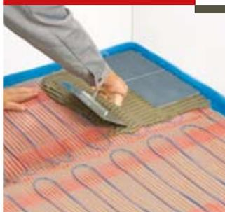
Укладывайте плитку, нанося клеящий состав с помощью епосредственно на мат. Во влажных помещениях до укладки плитки сначала нанесите тонкий слой клея на раскатанный мат, а затем нанесите слой гидроизоляционного покрытия.
