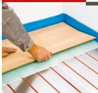
Положите подложку поверх пластин T2Reflecta и уложите напольное покрытие в соответствии с инструкциями производителя.
