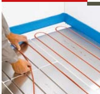
Уложите кабель T2Red в пазы. Исходя из рассчитанной мощности обогрева, шаг укладки может быть 100, 200 или 300мм.
