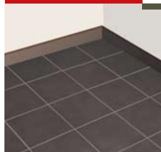
Уложив плитку, герметизируйте швы силиконом. До включения системы обогрева необходимо дождаться полного высыхания и отвердевания клея.
