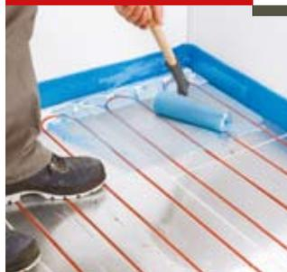
Нанесите грунтовку P-Fix на поверхность пластины, стараясь равномерно покрыть весь алюминиевый слой.
