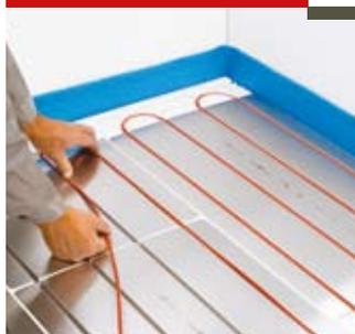
Поместите греющий кабель T2Red в пазы. Мощность обогрева определяется шагом укладки кабеля.
