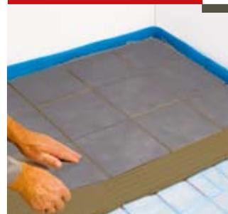
Керамическая плитка укладывается непосредственно поверх пластин T2Reflecta и фиксируется с помощью клеящего состава в соответствии с инструкциями. Примерно через 24 часа после укладки керамической плитки, вы сможете наслаждаться своим замечательным теплым полом.
