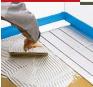
Нанесите клеящий состав A-FIX для пластин T2Reflecta на «черный» пол, шурупов. Положите пластины T2Reflecta сверху на клеящий состав. Также можно закрепить пластины с помощью шурупов (прибл. 15 шт. на одну пластину).
