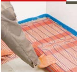
Подготовьте основание пола, очистив его от строительного мусора и пыли. Для лучшей адгезии плиточного клея рекомендуется нанести слой грунтовки. Разверните греющий мат, «вписав» его в границы подлежащей обогреву зоны. Благодаря липкой поверхности сетки, мат фиксируется на основании легко и быстро.
